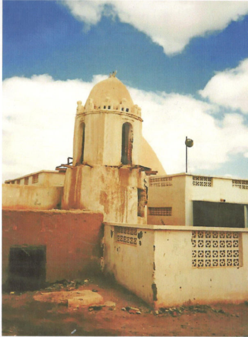
منظر خارجي للمسجد EXTERNAL VIEW OF THE MOSQUE
