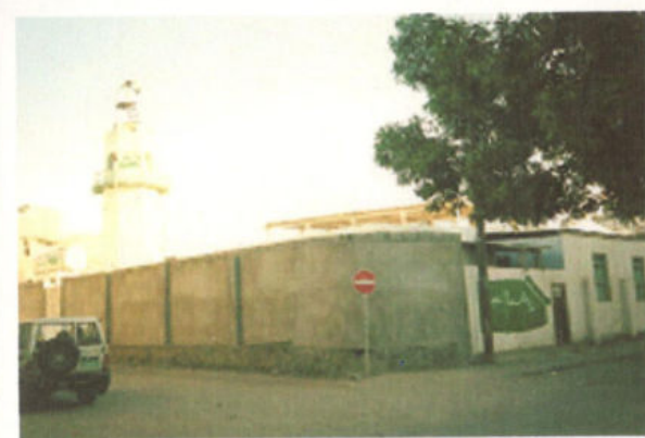
منظر خارجي للمسجد EXTERNAL VIEW OF THE MOSQUE
