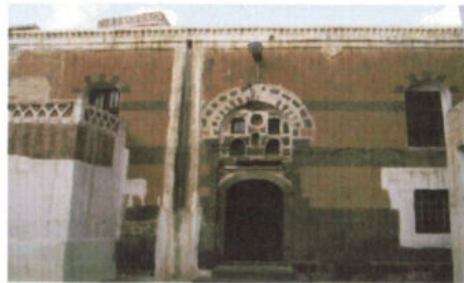
منظر خارجي للمسجد EXTERNAL VIEW OF THE MOSQUE
