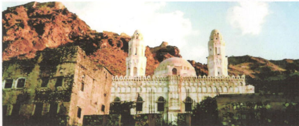
منظر خارجي للمسجد EXTERNAL VIEW OF THE MOSQUE
