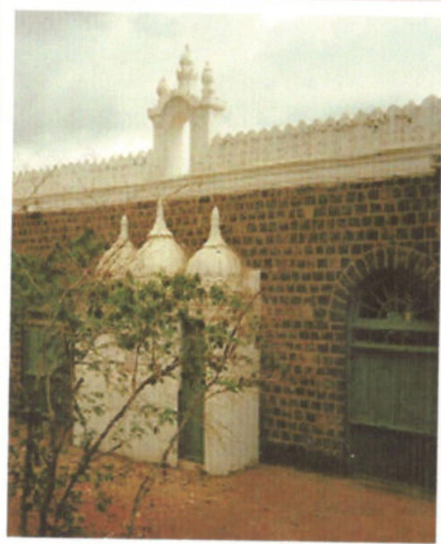
منظر خارجي للمسجد EXTERNAL VIEW OF THE MOSQUE
