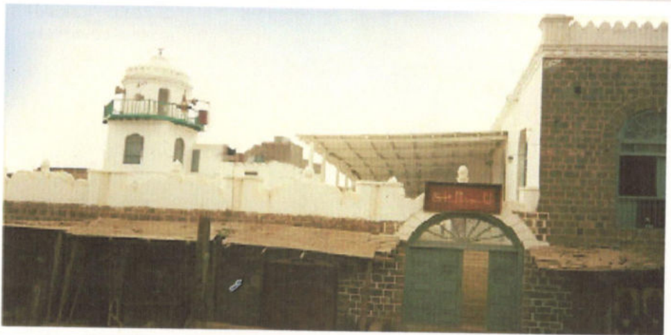
منظر خارجي للمسجد EXTERNAL VIEW OF THE MOSQUE
