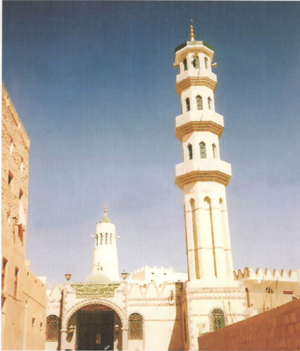
منظر خارجي للمسجد EXTERNAL VIEW OF THE MOSQUE
