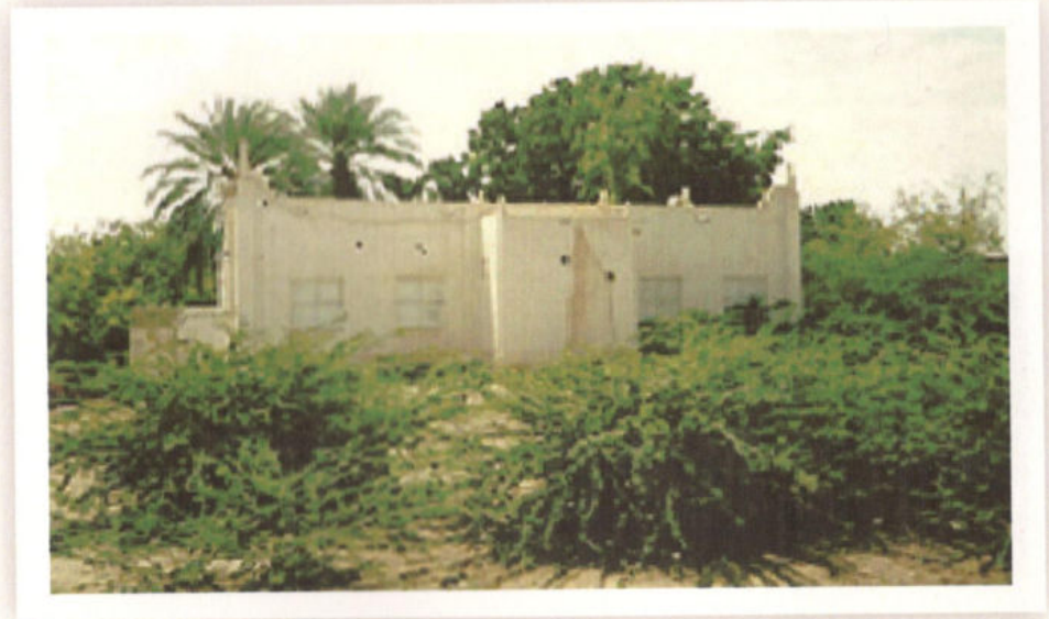
منظر خارجي للمسجد EXTERNAL VIEW OF THE MOSQUE
