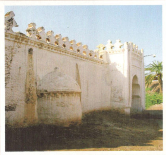
منظر خارجي للمسجد EXTERNAL VIEW OF THE MOSQUE
