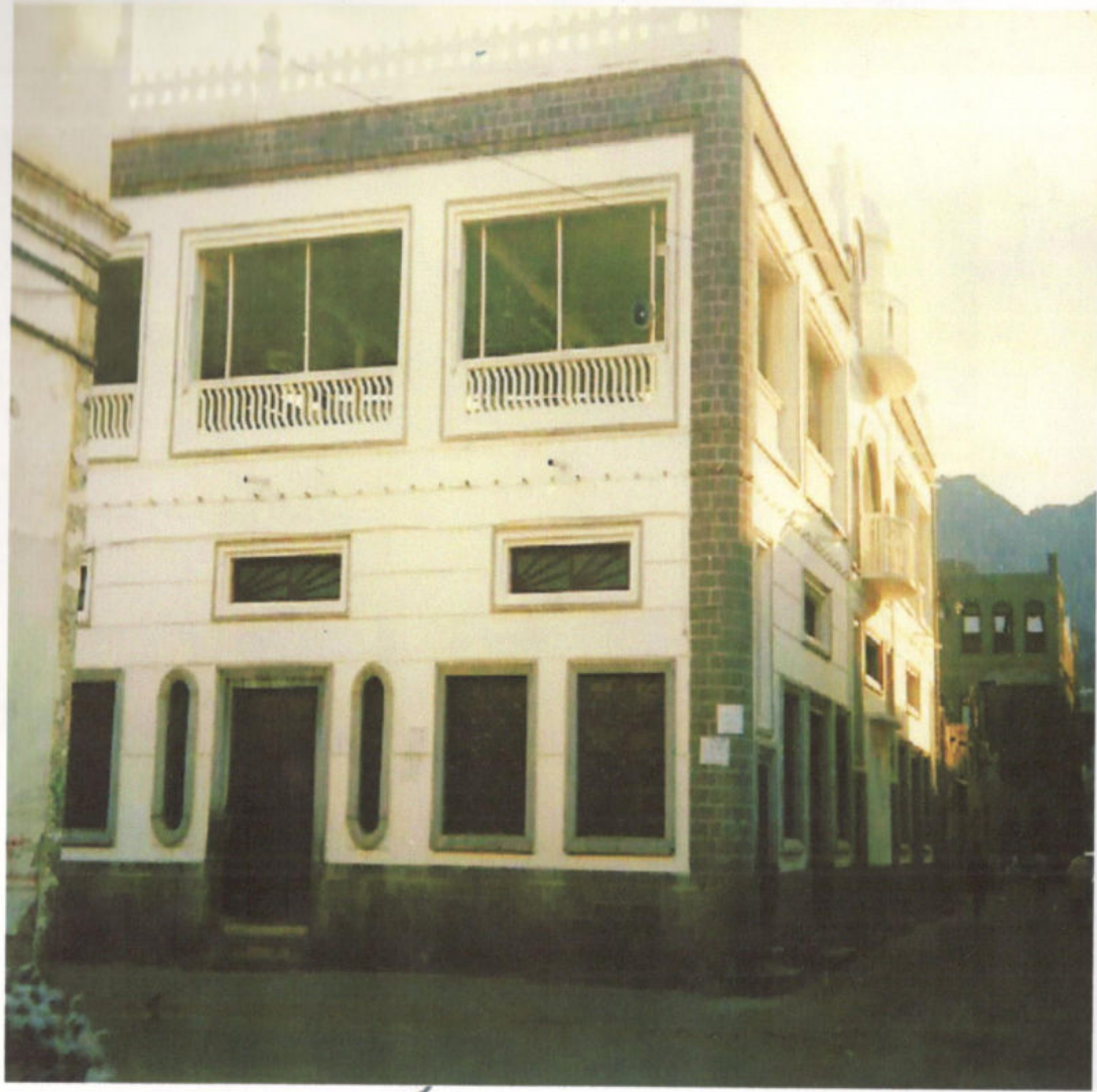
منظر خارجي للمسجد EXTERNAL VIEW OF THE MOSQUE
