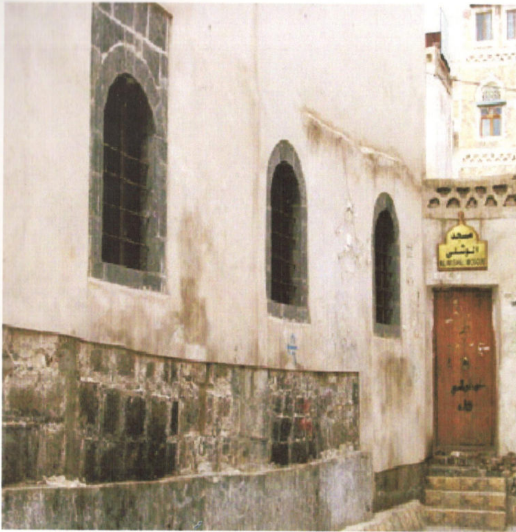
منظر خارجي للمسجد EXTERNAL VIEW OF THE MOSQUE
