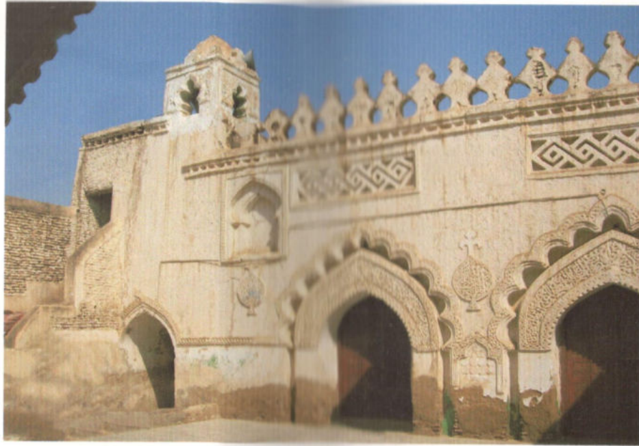
منظر خارجي للمسجد EXTERNAL VIEW OF THE MOSQUE
