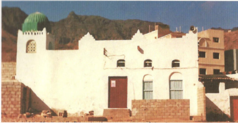
منظر خارجي للمسجد EXTERNAL VIEW OF THE MOSQUE
