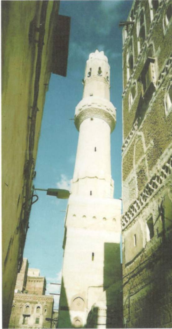
منظر خارجي للمسجد EXTERNAL VIEW OF THE MOSQUE
