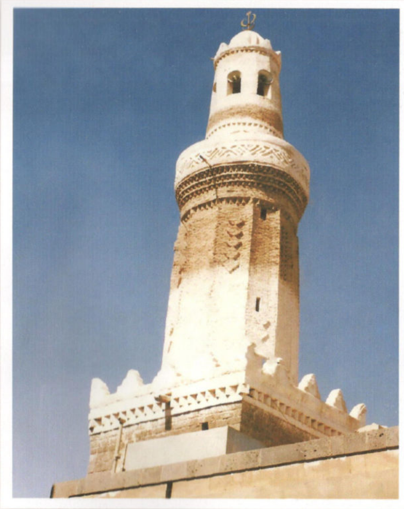
منظر خارجي للمسجد EXTERNAL VIEW OF THE MOSQUE
