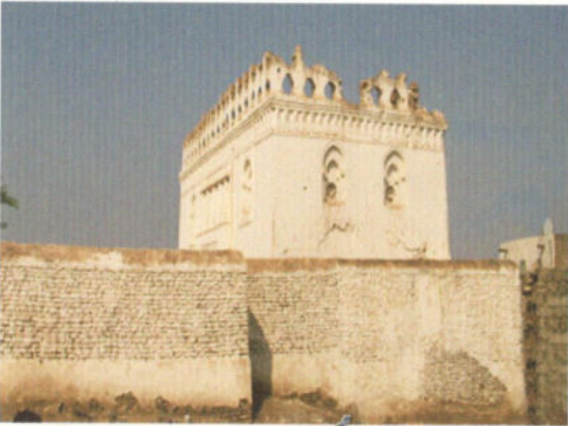
منظر خارجي للمسجد EXTERNAL VIEW OF THE MOSQUE
