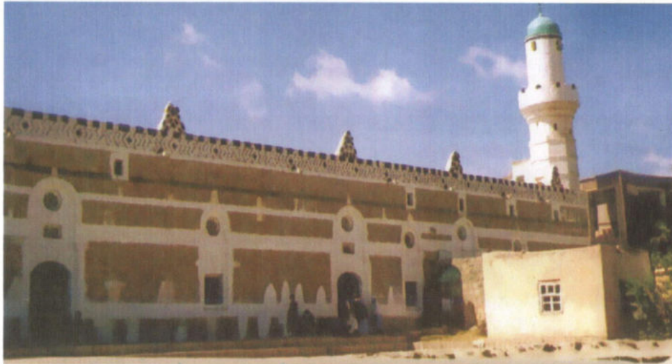
منظر خارجي للمسجد EXTERNAL VIEW OF THE MOSQUE
