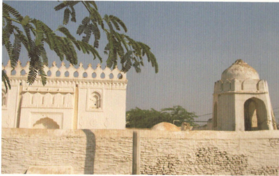
منظر خارجي للمسجد EXTERNAL VIEW OF THE MOSQUE
