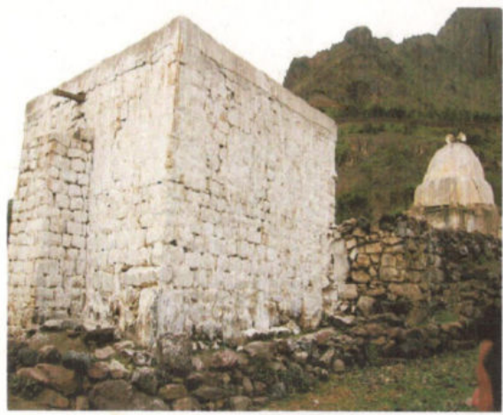
منظر خارجي للمسجد EXTERNAL VIEW OF THE MOSQUE
